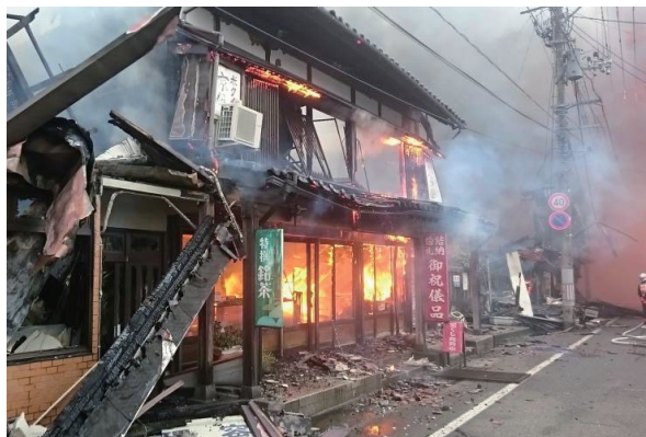
出火場所から約200m離れた場所にも火の手が (糸魚川市消防本部提供)
